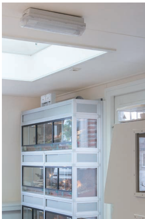
Foto 6: Noodverlichting aan het plafond is aan te bevelen. Zo kan men bij stroomuitval altijd nog verzorgen of in veiligheid brengen. Foto: André Weima. Photo 6: Emergency lighting should be installed at the ceiling. This is highly convenient in case of a general power breakdown to take the necessary precautions. Photo: André Weima.
