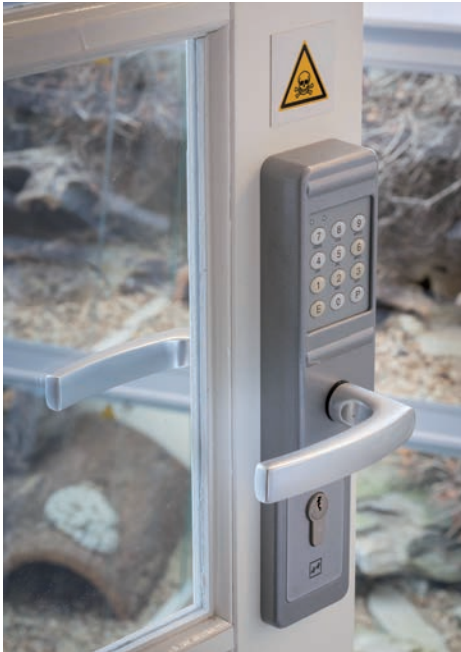
Foto 3: De toegang moet altijd beveiligd zijn. Een elektronisch slot met toegangscode is raadzaam en eigenlijk zelfs noodzakelijk. Foto: André Weima. Photo 3: The entrance should always be secured. An electronic lock with an secure code is advisable and even necessary. Photo: André Weima.
