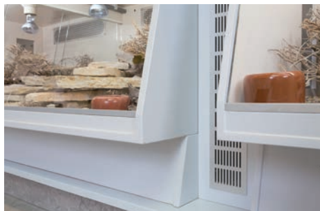
Foto 5: Om te verhinderen dat eventueel ontsnapte dieren weggroepen, mogen er geen kieren zijn tussen de terrarium, de muur en de vloer. Foto: André Weima. Photo 5: Narrow openings and small spaces in between enclosures should be avoided in order to prevent snakes to hide in hard to reach places. Photo: André Weima.
